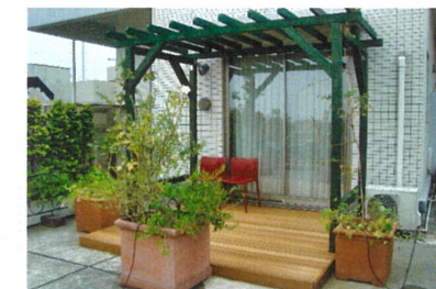
ウッドデッキ&パーゴラ設置
