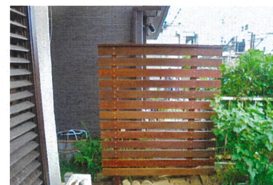
目隠し用のウッドフェンス設置
