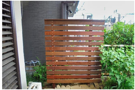
目隠し用のウッドフェンス設置
