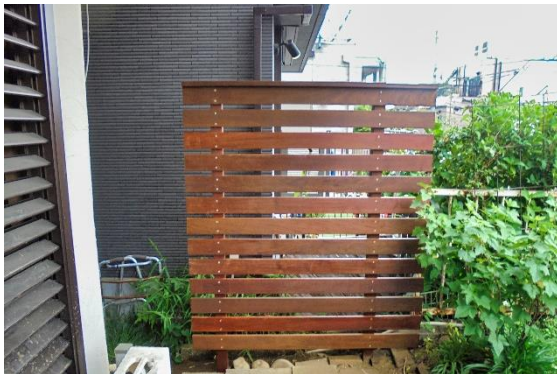
目隠し用のウッドフェンス設置
