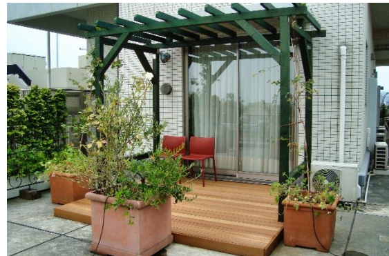
ウッドデッキ&バーゴラ設置
