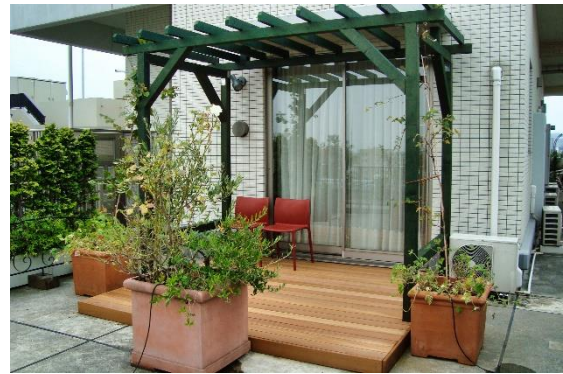
ウッドデッキ&バーゴラ設置
