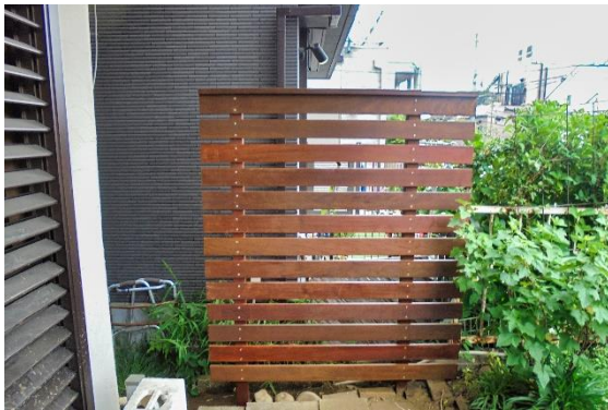
目隠し用のウッドフェンス設置
