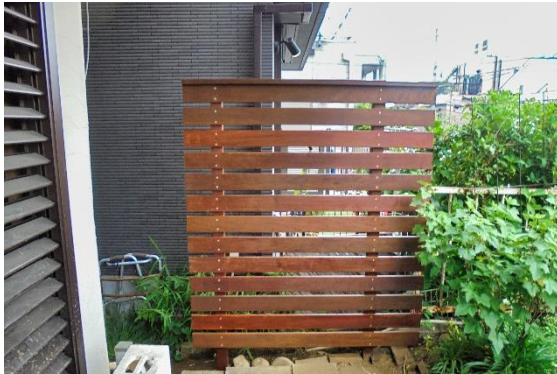
目隠し用のウッドフェンス設置
