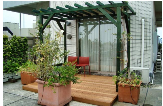
ウッドデッキ&バーゴラ設置
