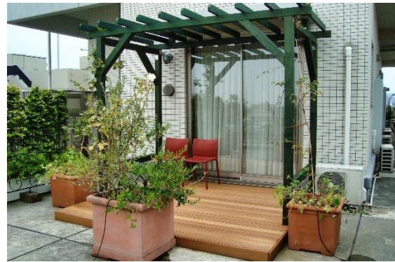
ウッドデッキ&バーゴラ設置
