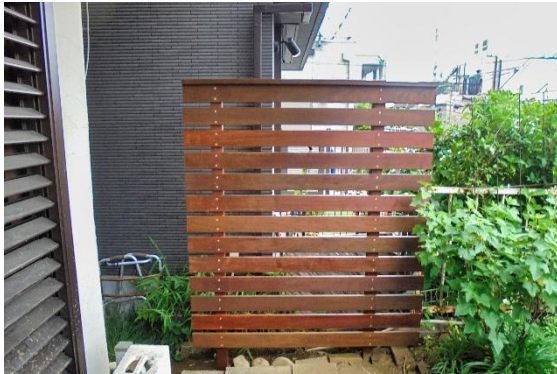
目隠し用のウッドフェンス設置
